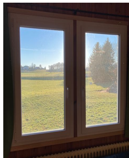
Die neuen Fenster
