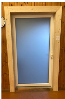
Die neue Hintertüre
